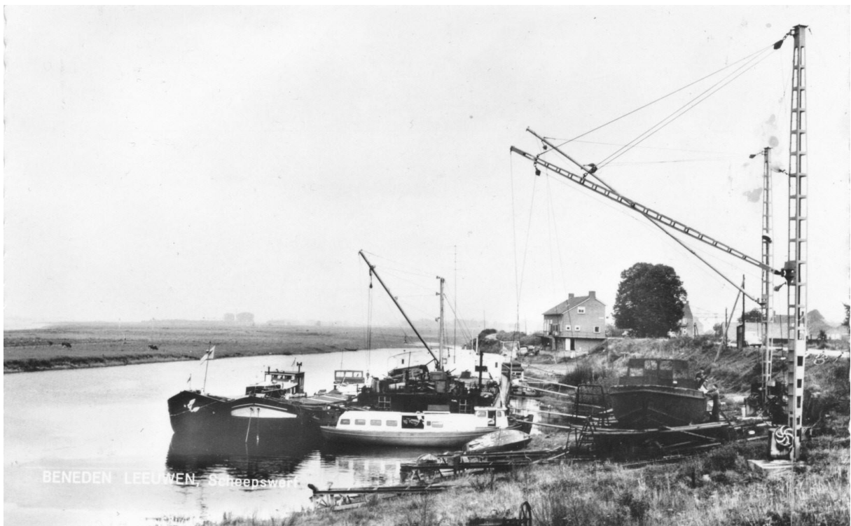
Helling met op de voorgrond een bedrijfsvaartuig in aanbouw. De pas gereed zijnde 'Dor Lei' van Thé Scheers en enkele aange- meerde schepen. De kranen staan op de helling en op het werkschip.
